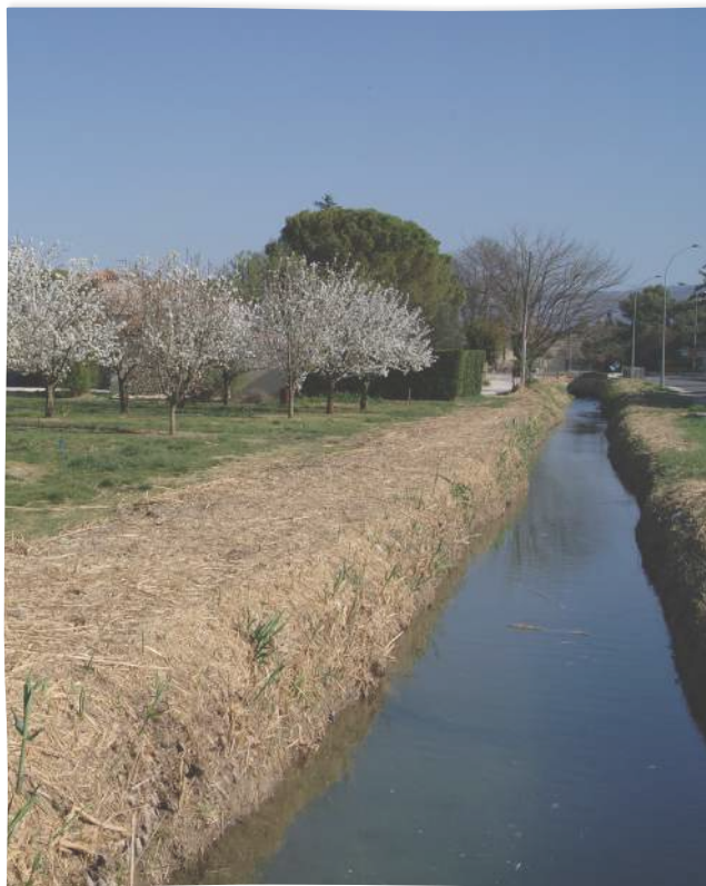
Canal principal de l'Isle © Canal de l'Isle
